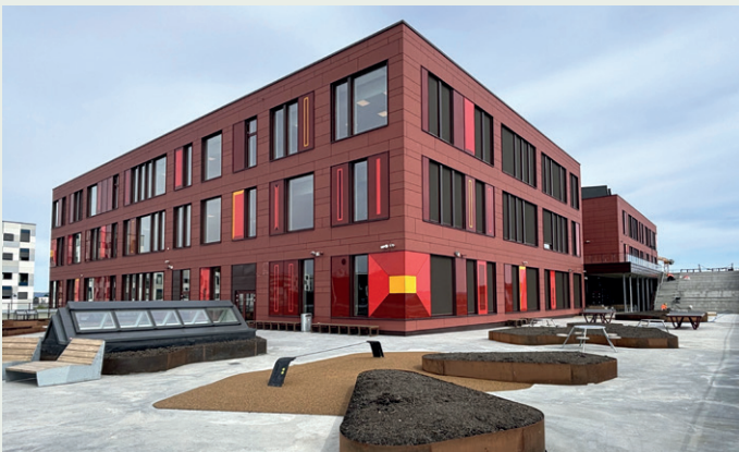
Fra hovednivået på takterrassen. Beplantingene blir del av undervisningen.
